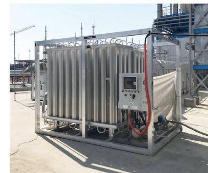
Рис. 11. Атмосферный испаритель жидкого гелия производства ООО «Мониторинг Вентиль и Фитинг» из сплава 6061-T6
