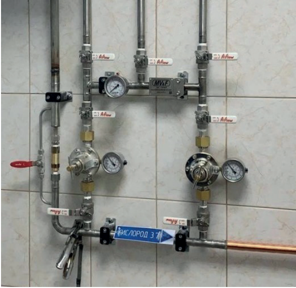
Рис. 3. Монтаж газового щита MV&F с регуляторами давления RegO в ковидном госпитале в Москве, май 2020 г.
